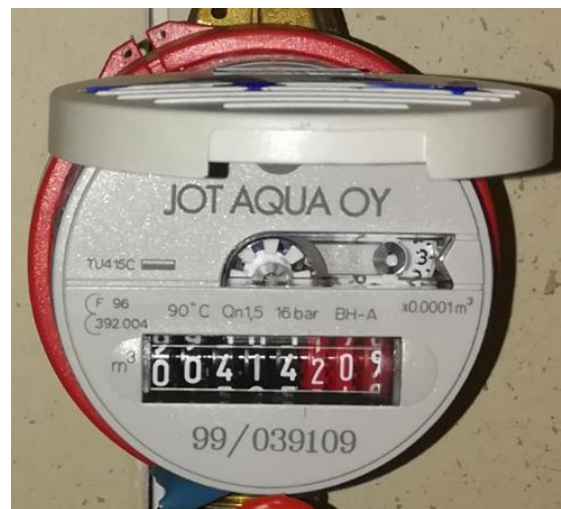
Esimerkki 4: Mittarin rullalaskurissa näkyy täysien kuutioiden (mustalla) lisäksi kolme desimaalia (punaisella), joita ei ilmoiteta. Ilmoitettava lukema on 414.
