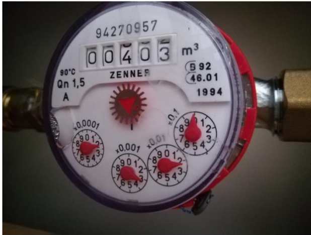
Esimerkki 1: Mittarin rullalaskurissa näkyy ainoastaan täydet kuutiot (m 3 ). Ilmoitettava lukema on 403.
