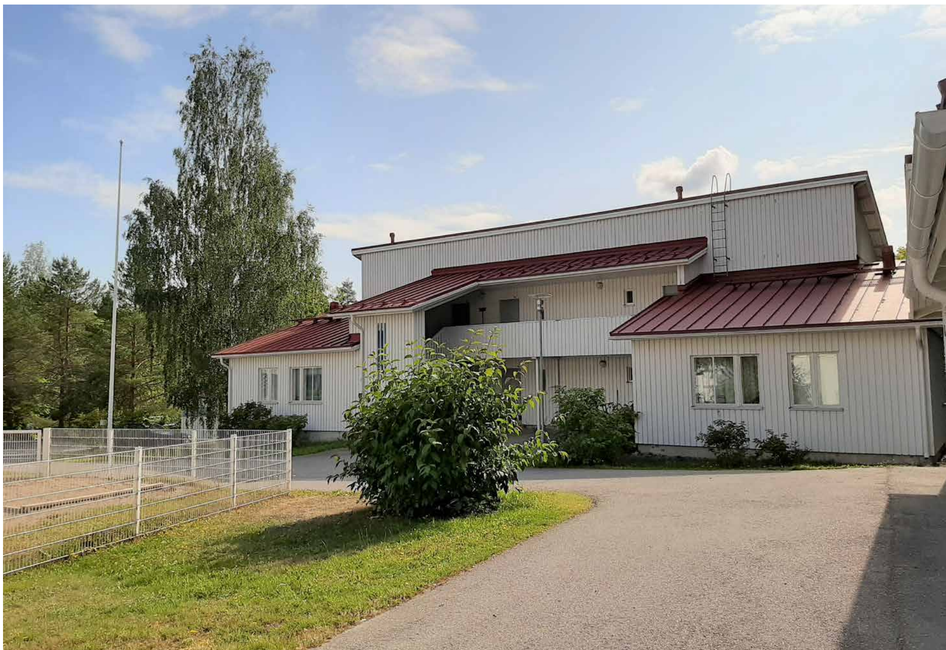
Kielonsaarenkatu 2:ssa tehtiin Koti kuntoon -remontti. Lisää kuvia kohteesta https://www.niiralankulma.fi/niiralan-kulma/remontointi/koti-kuntoon-remontit.html
