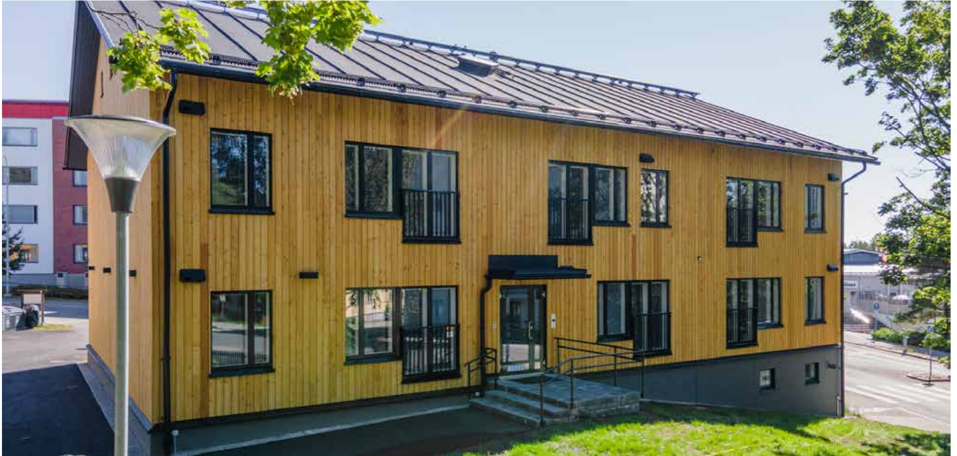
Puuverhoiltu pienkerrostalokohde Untamonkatu 2 valmistui kesällä 2022 Männistöön.
