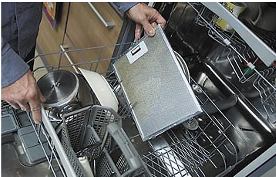
3. Useimmat rasvasuodattimet voidaan pestä myös astianpesukoneessa. Asia on hyvä tarkistaa valmistajan huolto-ohjeesta. Suodattimen annetaan kuivua ennen takaisin asentamista.
