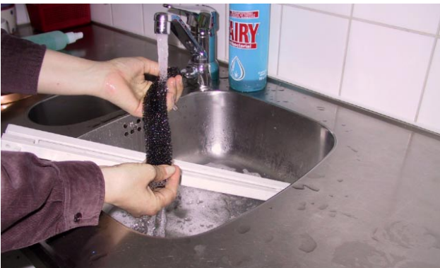
4. Raitisilmaventtiilin sisällä on suodatin, jonka voi pestä vedellä ja astianpesuaineella.
