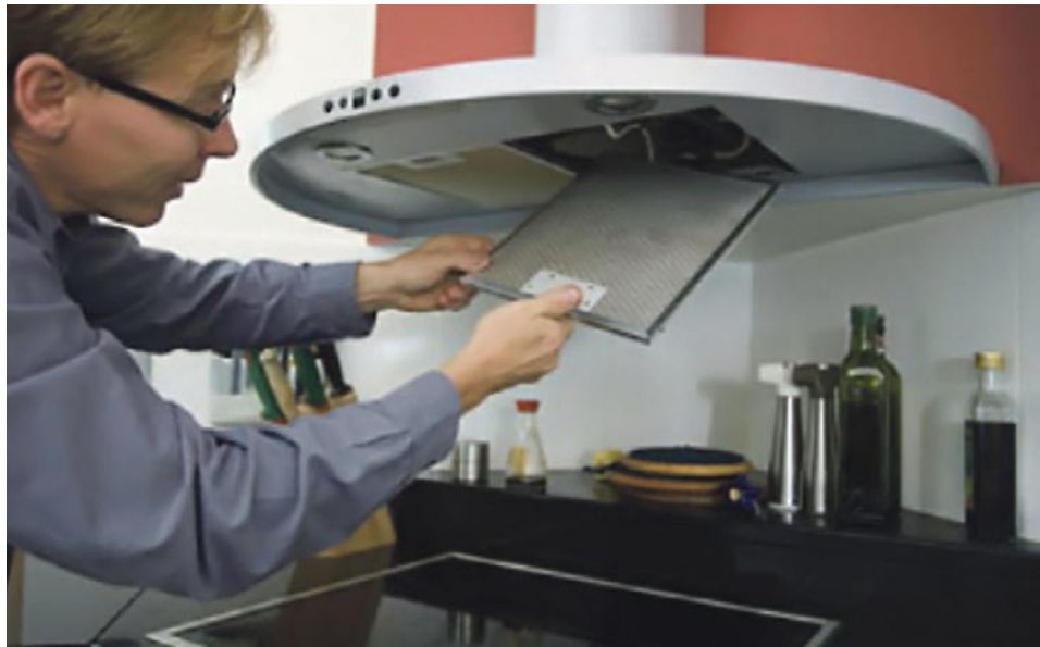
1. Liesituulettimen alapinnalla sijaitseva rasvasuodatin irrotetaan. Rasvasuodattimien puhdistusväli vaihtelee 1-3 kk.
