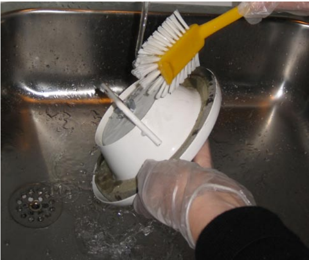
2. Pese likaantunut venttiili kiertämättä keskellä olevaa säätöosaa. Keskellä olevan säätöosan ja kauluksen väliin jäävä rako on pidettävä puhtaana, se vaikuttaa venttiilin poistotehoon.
