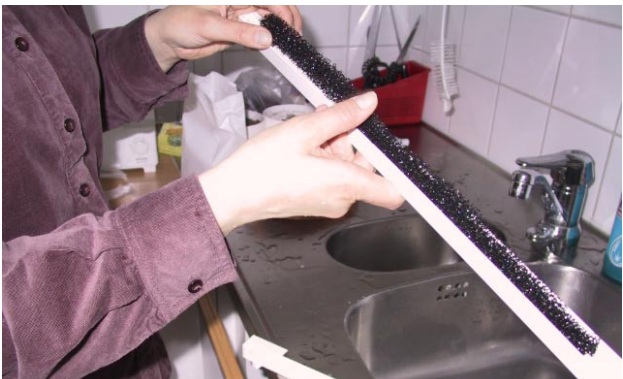
6. Kokoa puhdistetut osat paikoilleen. Huomaa, että ilman pitää heittää ylöspäin. Näin ei synny vedontunnetta auki olevasta venttiilistä. Puhdista raitisilmaventtiili kaksi kertaa vuodessa, keväällä ja syksyllä.
