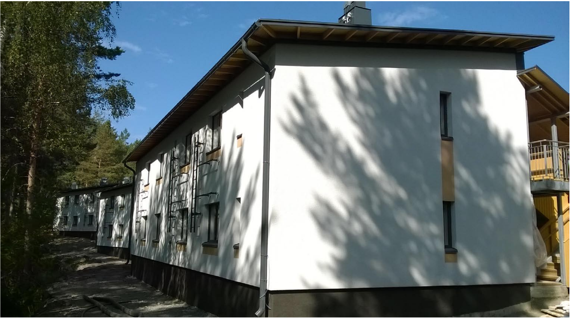
Neulamäentie 22 julkisivu peruskorjauksen jälkeen.
