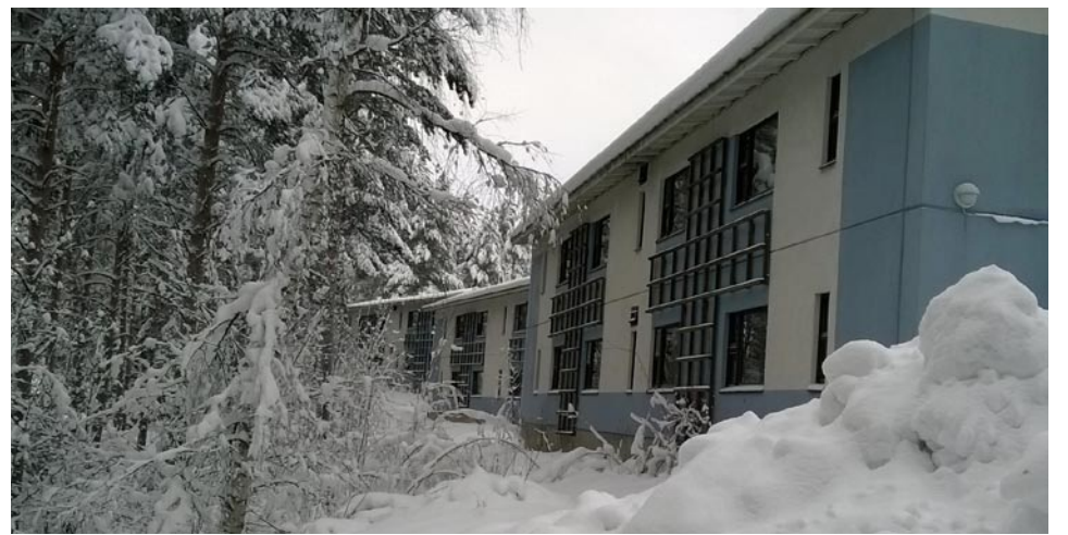
Neulamäentie 22 julkisivu ennen peruskorjausta.
