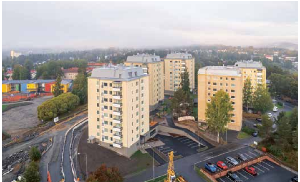
Urheilukatu 3 on viimeinen Haapaniemen viiden pistetalon uudistushankkeen taloista. Myllymäen korttelista on viimeisen 7 vuoden aikana purettu ja uudelleenrakennettu neljä taloa ja peruskorjattu yksi talo. Kuvassa vanha Urheilukatu 3 on toinen talo oikealla.
